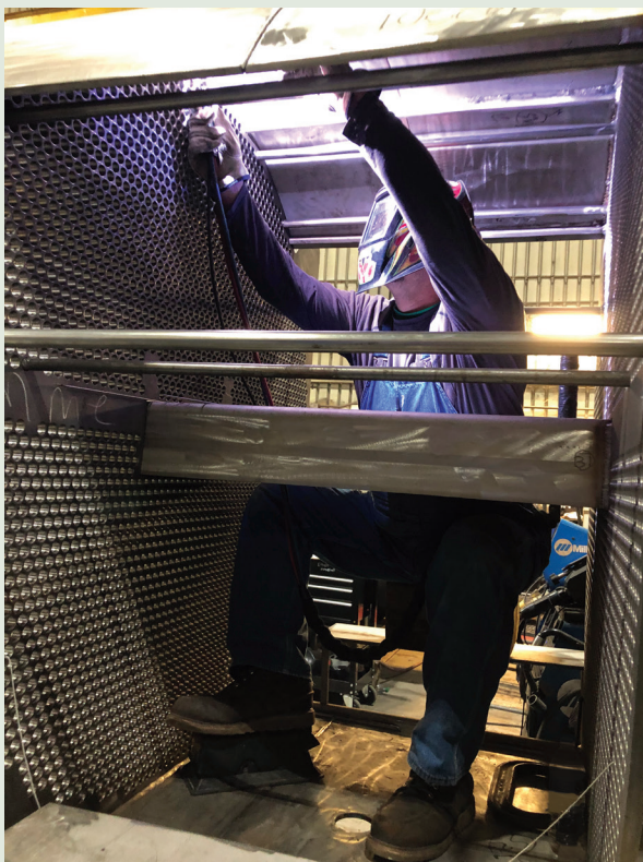
Fig. 3 — Los soldadores observadores realizan soldadura por arco de tungsteno con gas (GTAW) en placas tubulares en la fabricación de un calentador de agua de alimentación.
