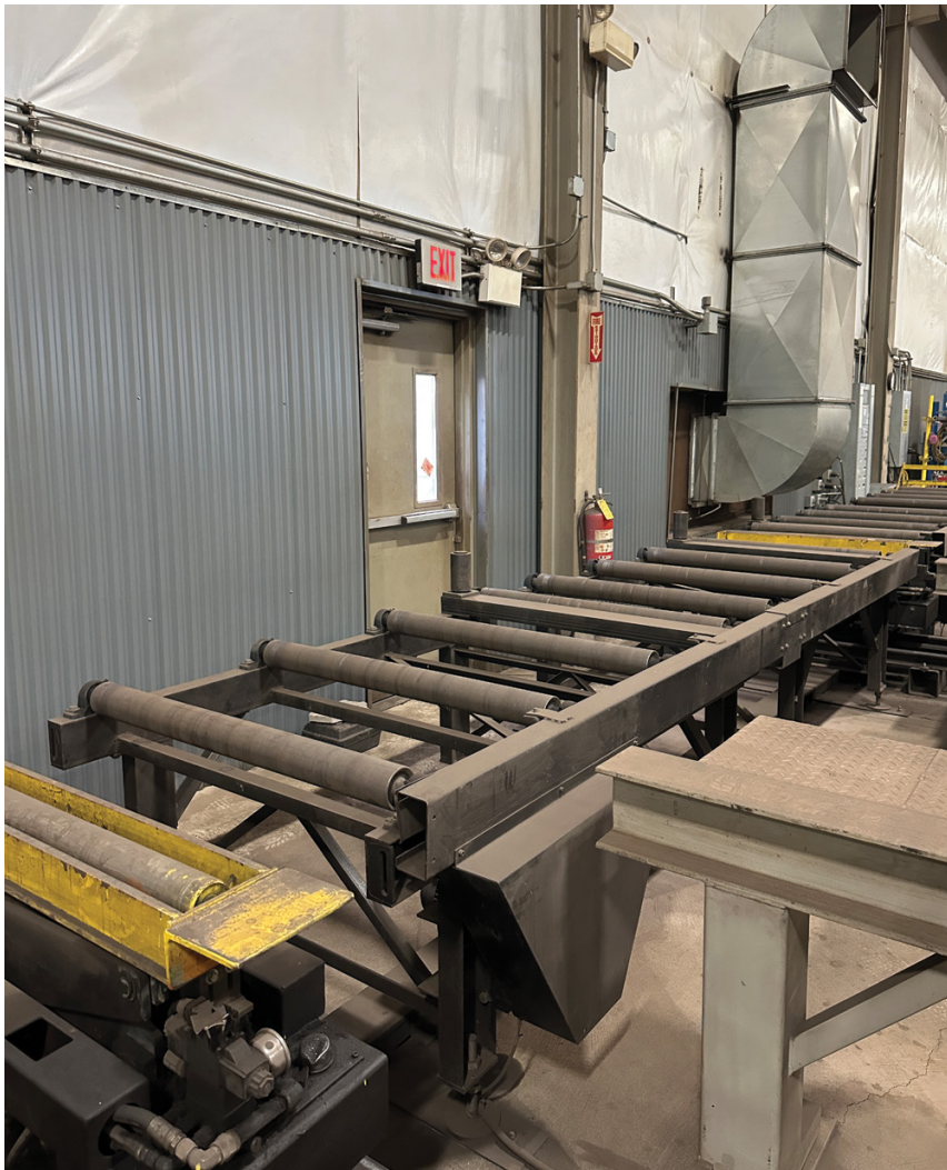
Una salida obstruida después de la instalación de nuevo equipo.
