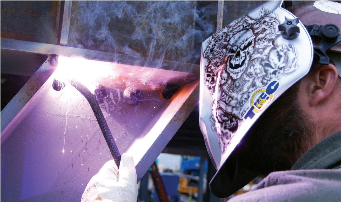
*Fig. 1 — cambiar a un alambre de soldadura con núcleo de fundente autoprotegido para proyectos que requieren soldaduras de multipasadas más grandes ofrece mayores tasas de deposición y eficiencia, lo que ayuda a los contratistas a completar los trabajos más rápido.*
