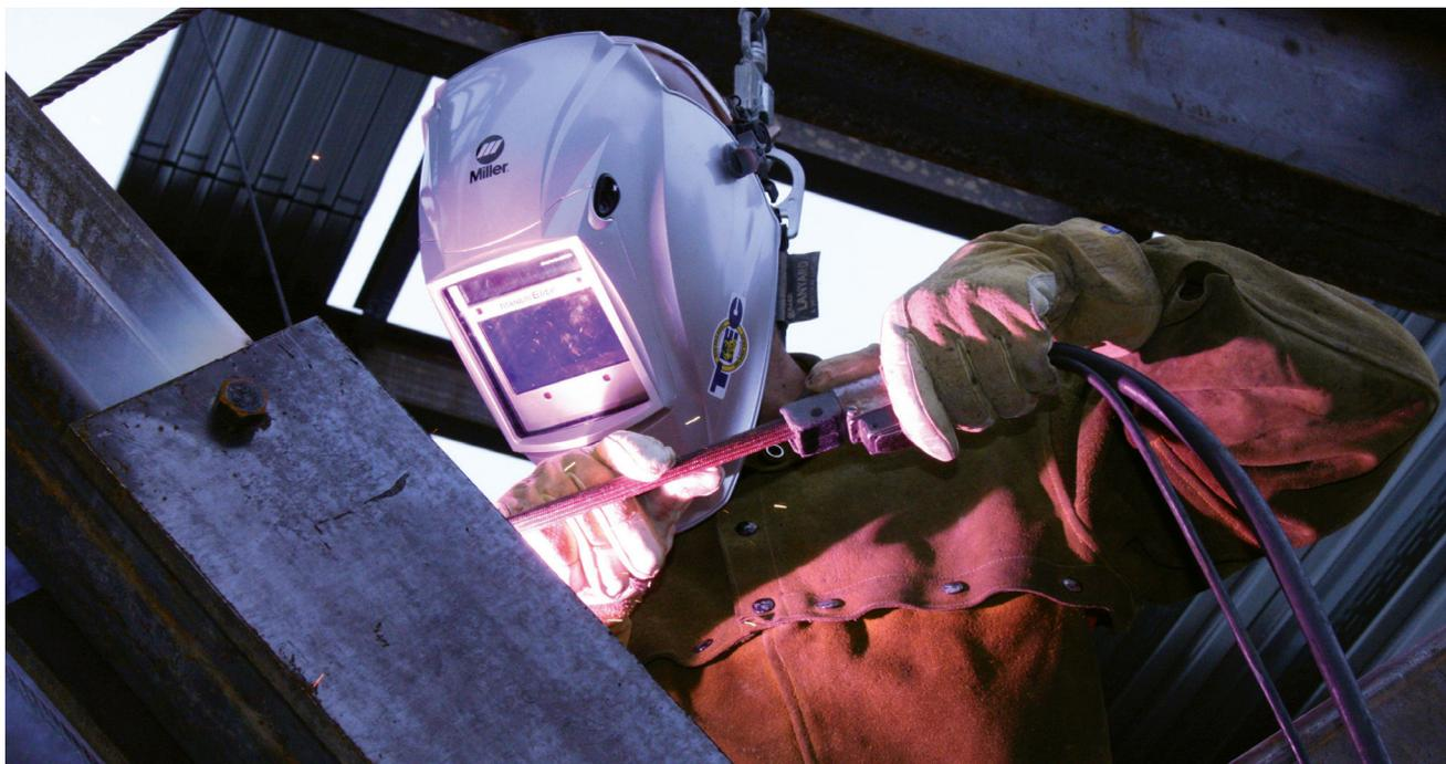
*Fig. 2 — La caída de voltaje en los cables de soldadura es un problema común con los procesos de soldadura de alambre en el lugar de trabajo. La caída de voltaje se puede reducir prestando atención a las longitudes excesivas de los cables, los cables que están en malas condiciones, los calibres inadecuados y cualquier impedancia al flujo de corriente en las conexiones.*
